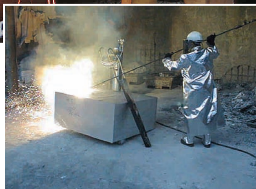
Betong skjæring
